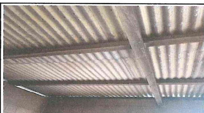
Foto 8: Sustitución de soporte de madera por costanera de metal en cocina
