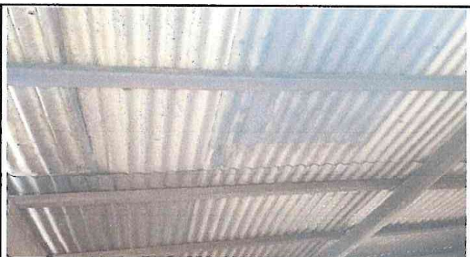
Foto 7: Sustitución de lámina acanalada por lámina troquelada en cocina
