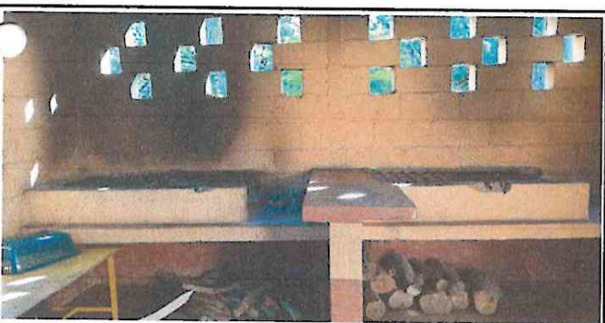
Foto 5: Sustitución de chimenea de concreto
